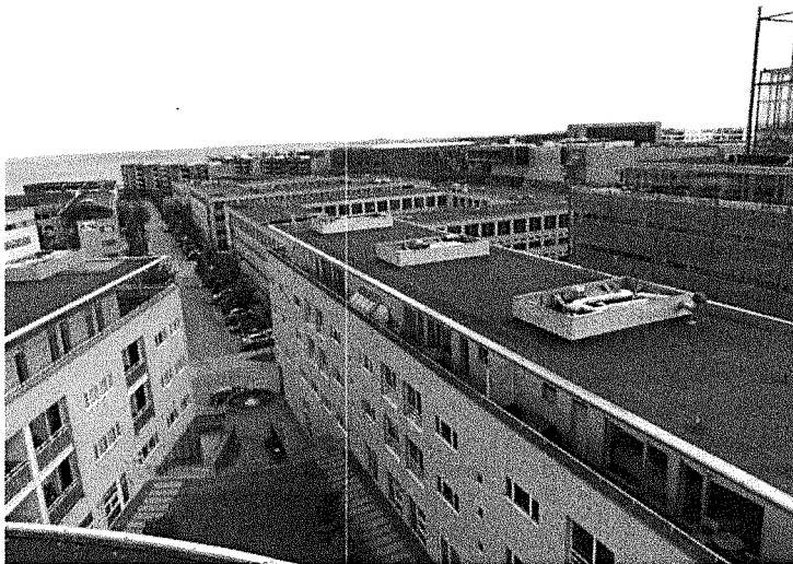
Terræn mellem bygning 1, 2 og 3. Lille Rotunde ses i baggrunden.
