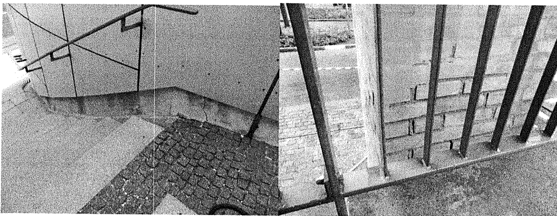
Murværk, der er afrenset før reparation og ny fildsning.
